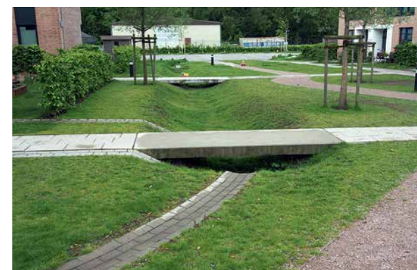
ABBILDUNG 3.5–5 ► Nutzung begrünter Flächen zur Versickerung von Regenwasser in einem Neubaugebiet in Hamburg. (Foto: Manfred Tschöpe)
